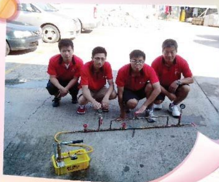
第三組水錶喉管安裝及水壓測試合格
