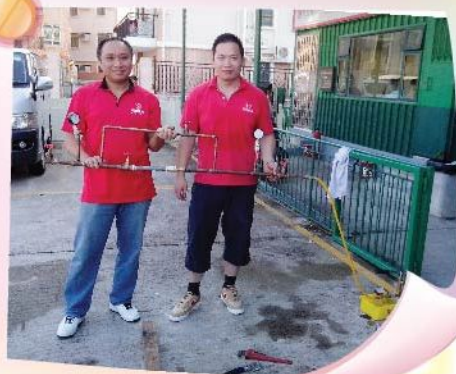
第二組水錶喉管安裝及水壓測試合格
