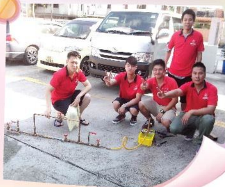
第一組水錶喉管安裝及水壓測試合格
